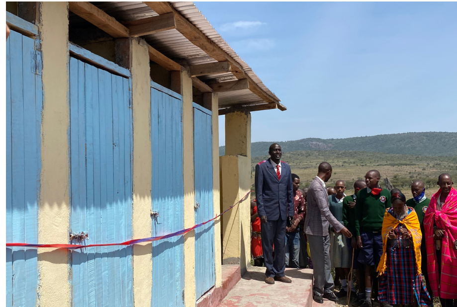
Construction de 8 toilettes sèches
